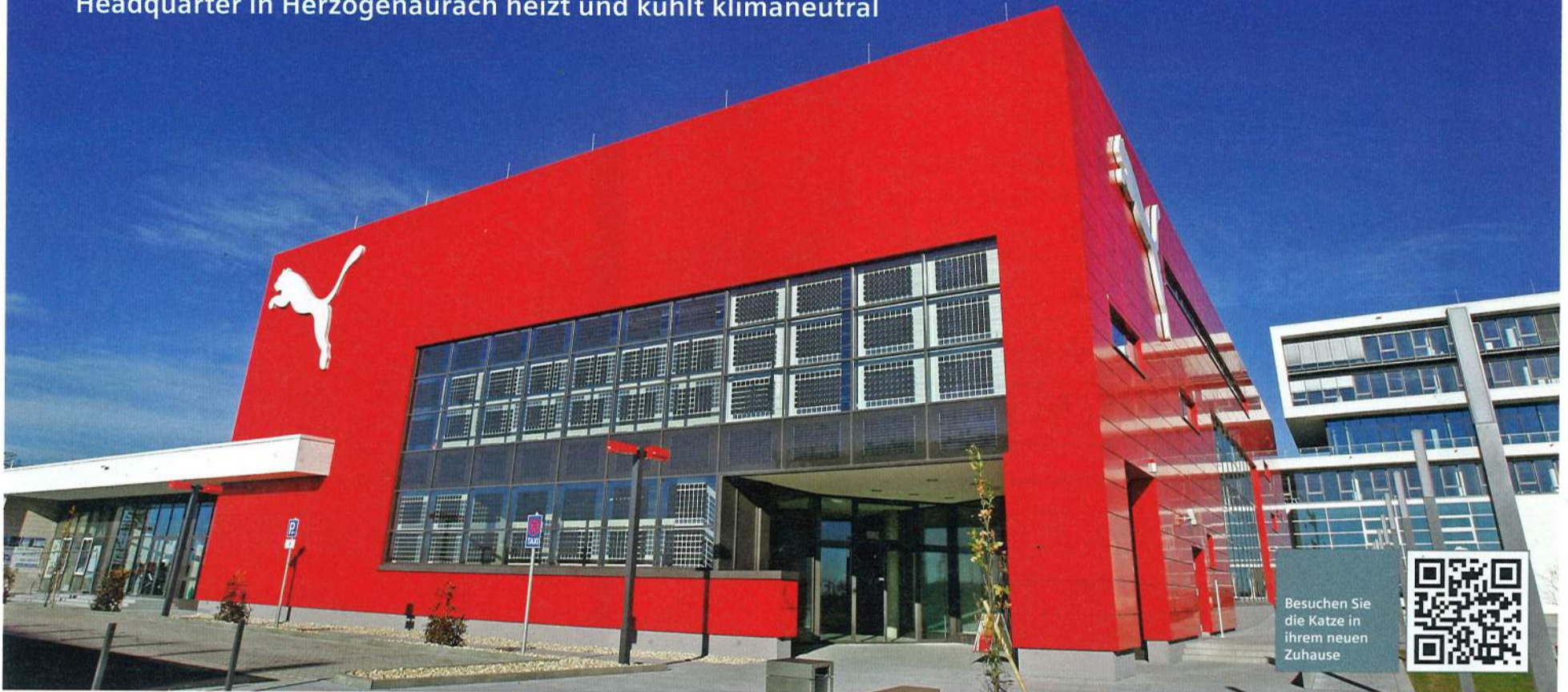
Auf dem neuen Campus der Puma AG werden alle HLK-Anlagen nach „bedarfsweckenden“ Regelungsprinzipien in Betrieb gesetzt.
